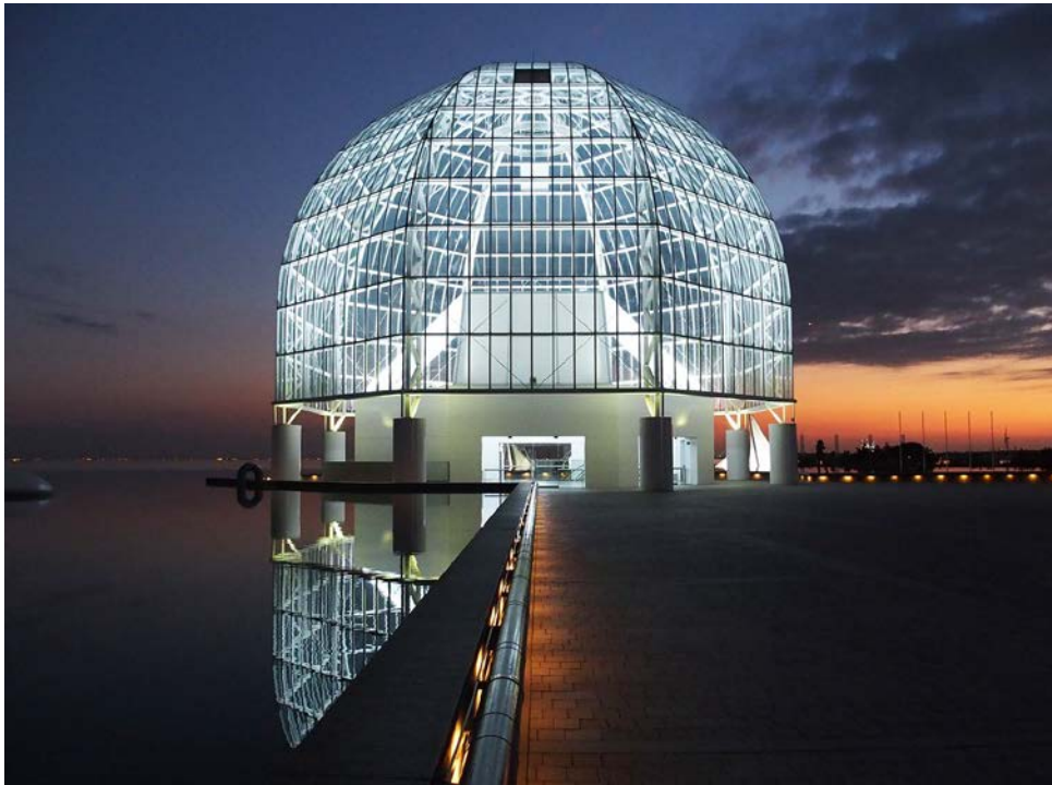
エントランスの広場、噴水池とガラスドーム 夜景
