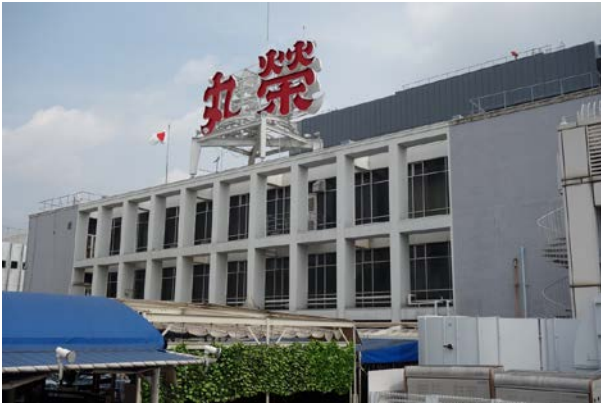
图9 丸栄本館 屋上搭屋
