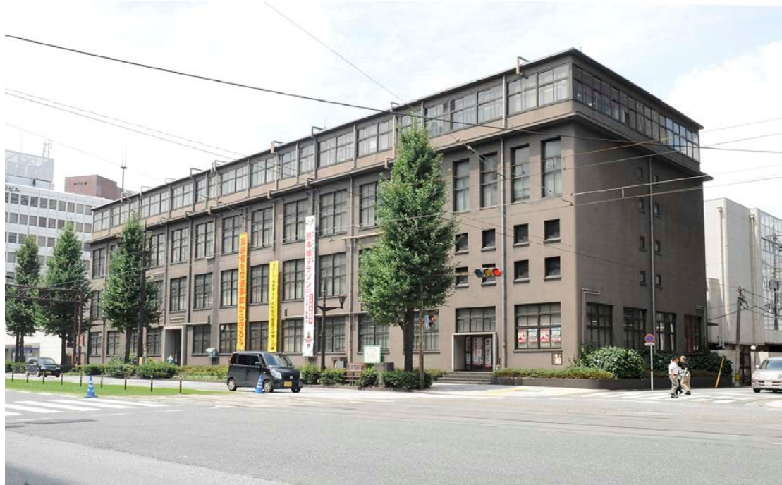
①外観。外装はタイルであったが、現在モルタルで塗られている。
