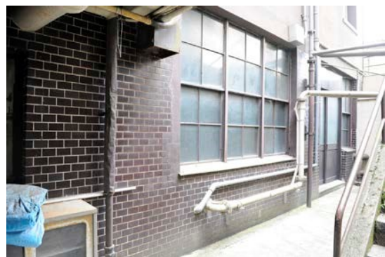
④地下部分。本来の外装のタイルが残る。
