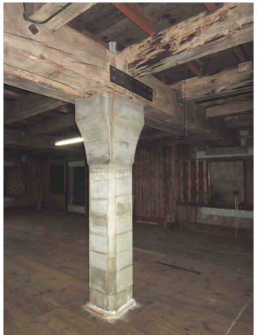
2階 RC柱と柱頂部の床組構造
