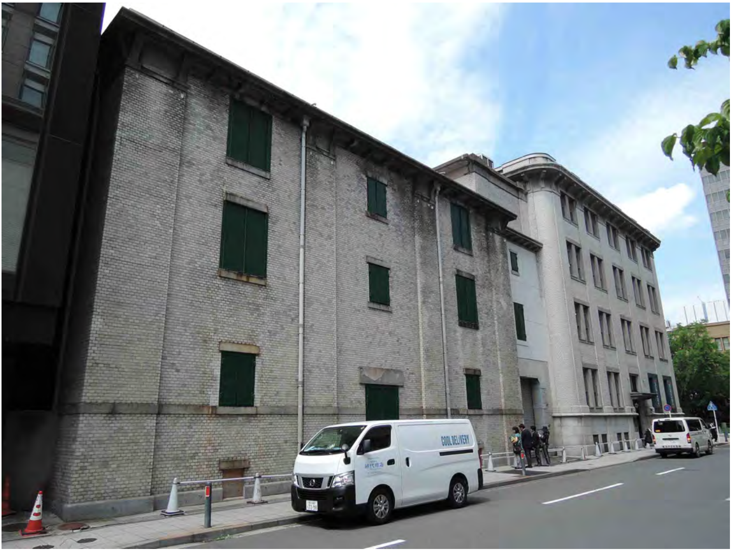
旧三井物産横浜ビル倉庫棟 海側側面
