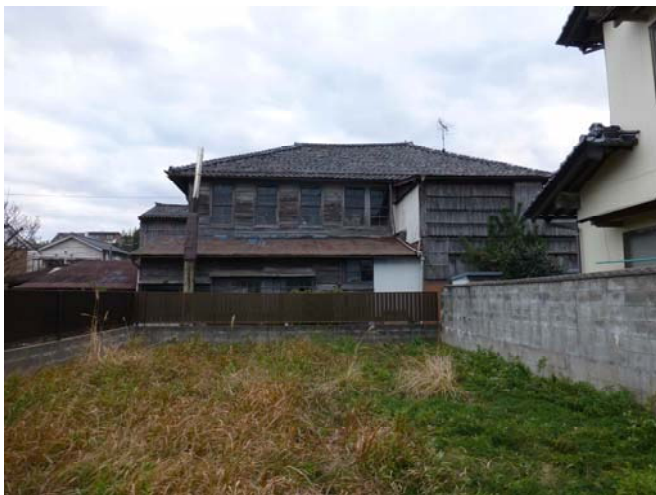
図 2 現況写真（2014.1）：初代松江警察署庁舎の正面側
