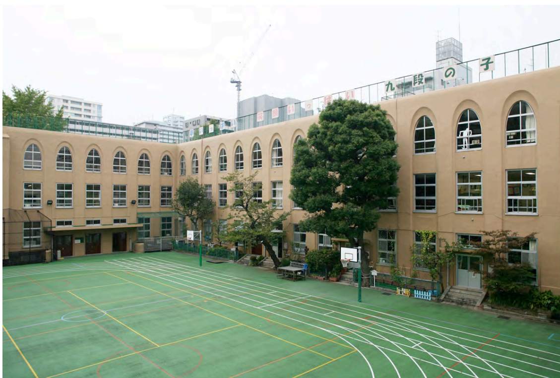
2. 校庭側立面：窓高が統一された立面（右校舎：普通教室、左校舎：廊下）撮影：山崎鯛介
