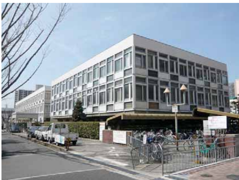
現状（東南方向より）
