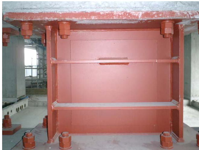
図2 鋼材ダンパーシステムの実施工例
