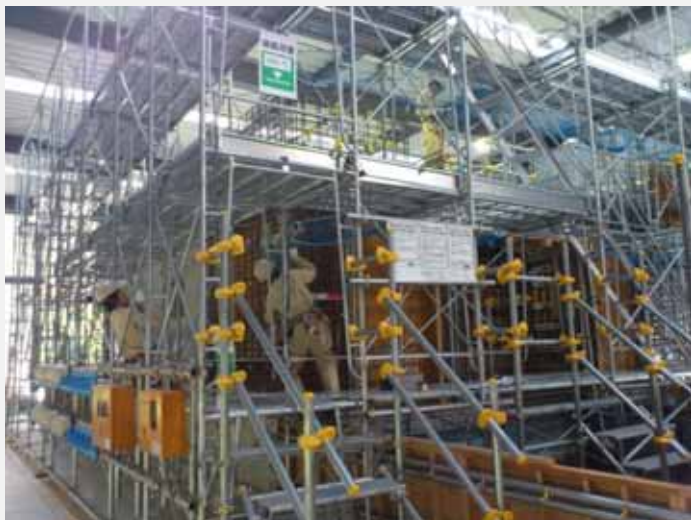
配筋検査実習
