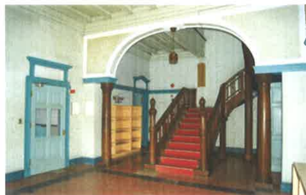
玄関ホールから階段まわりを見る
