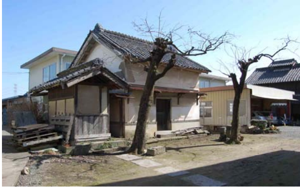
屋敷東側の外便所・穀蔵・蚕室
