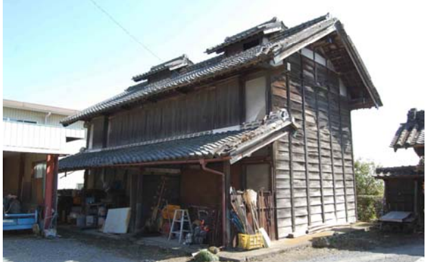
蚕室北面・西側面全景
