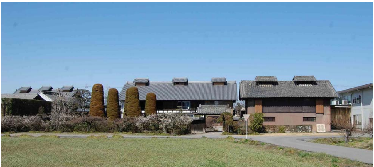
屋敷正面をみる(右が蚕室、中央が主屋で主屋前に表門が建つ)。写真左端は田島昭次家主屋
