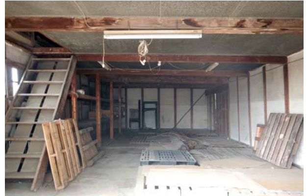
蚕室1階 東から西方を見る
