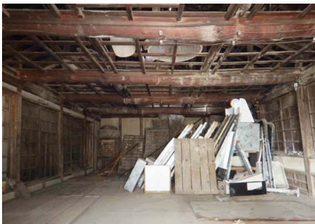
蚕室2階内部 東から西を見る
