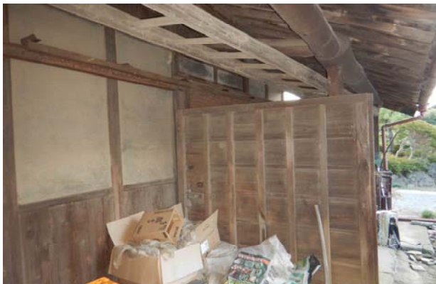
蚕室北面下屋の仮設間仕切り転用の旧大戸
