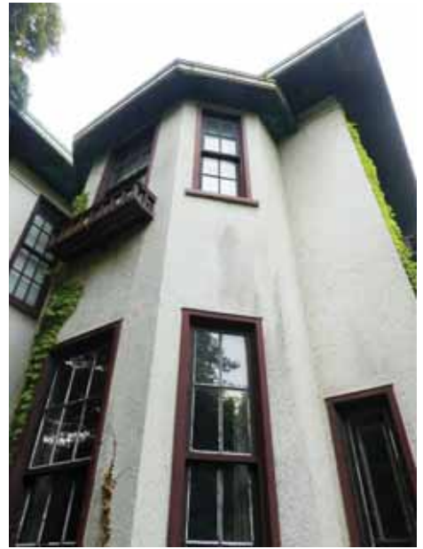
写真3 南東側 1階「御洋間」 2階「寝室」
