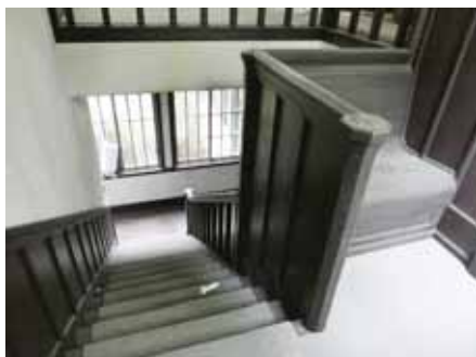
写真6 階段室の造付け
