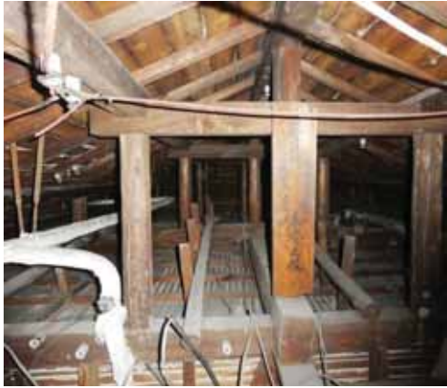
写真9 小屋裏の架構と棟札
