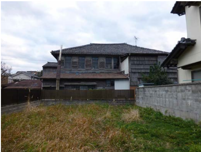
図 1 現況写真（2014）：初代松江警察署庁舎の正面側
