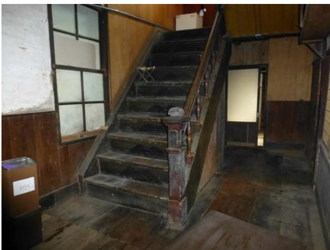
図 2 現況の内部写真（2014）
