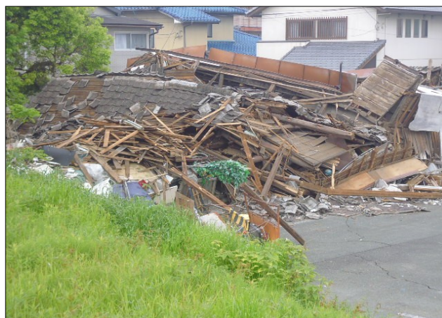
H28 年 4 月 熊本地震の被害
