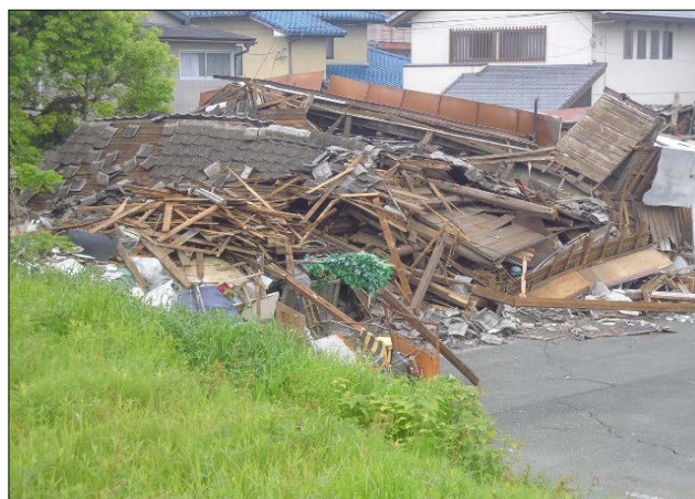
H28 年 4 月 熊本地震の被害
