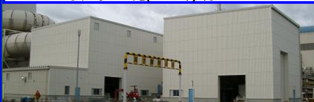
Y火力発電所構内廃棄物焼却炉 建物(2005年):約1,000m 3
